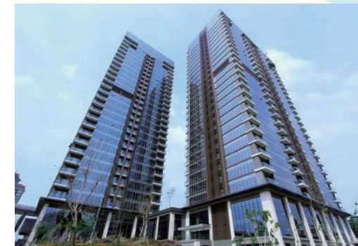
BRANZ SIMATUPANG(2018年12月竣工)
